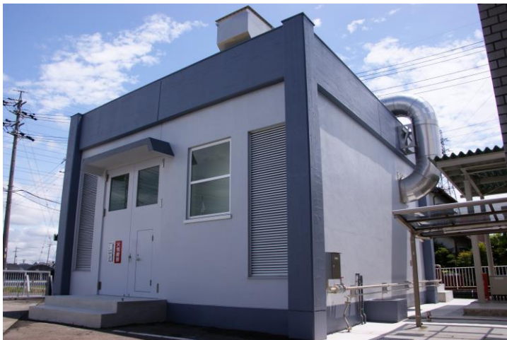
中央配水場自家発電設備
