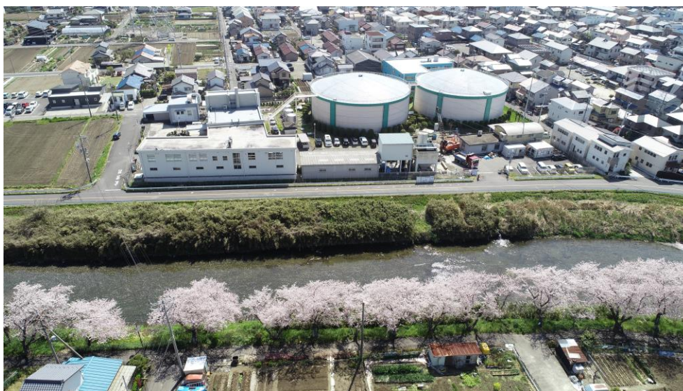
中央配水場全景
