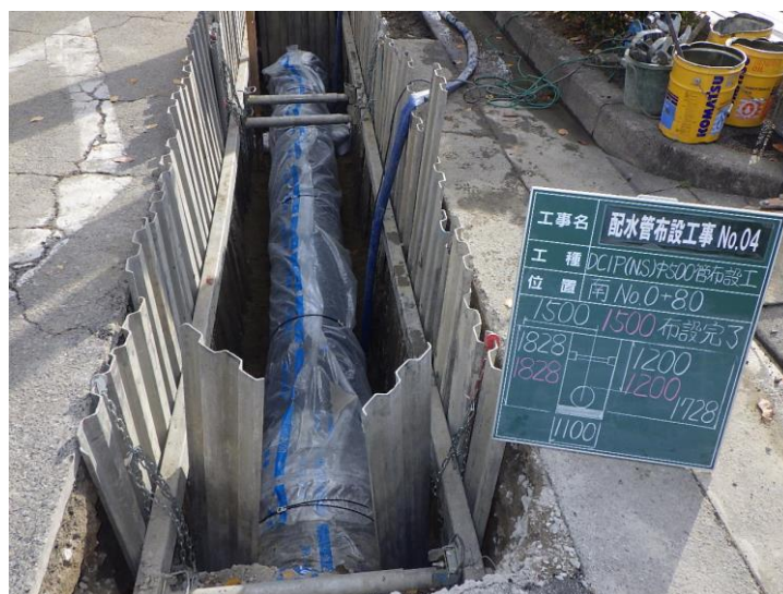
配水管布設工事（ダクティル鑄鉄管NS形継手口径500mm）
