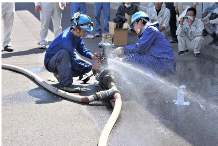
フランジ補強金具取付講習
