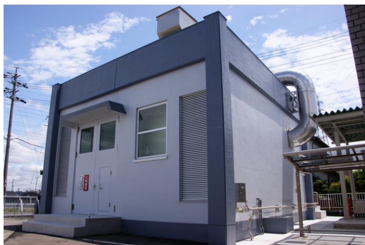
中央配水場自家発電設備
