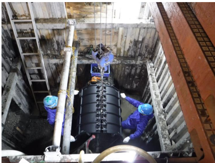
配水管布設替工事（不断水）
