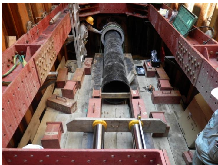
管路更新工事（推進工）
