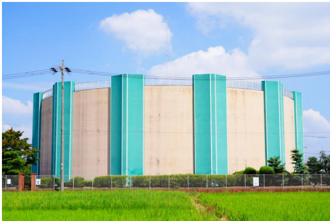
師勝配水場（配水池）
