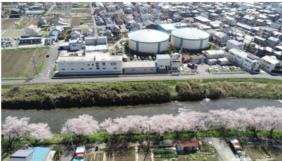
中央配水場全景
