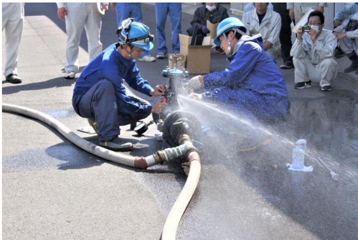
フランジ補強金具取付講習
