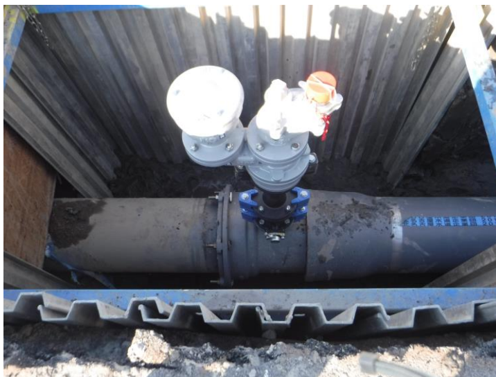
耐震管布設状況（空気弁接続部分耐震補強）
