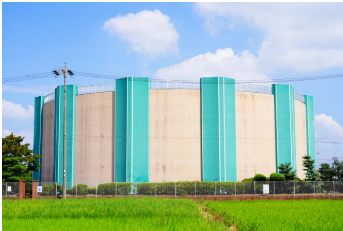
師勝配水場（配水池）
