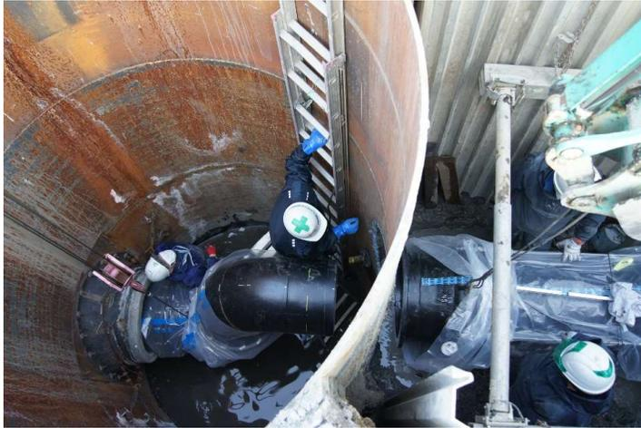
基幹管路布設状況写真（口径500mm）
