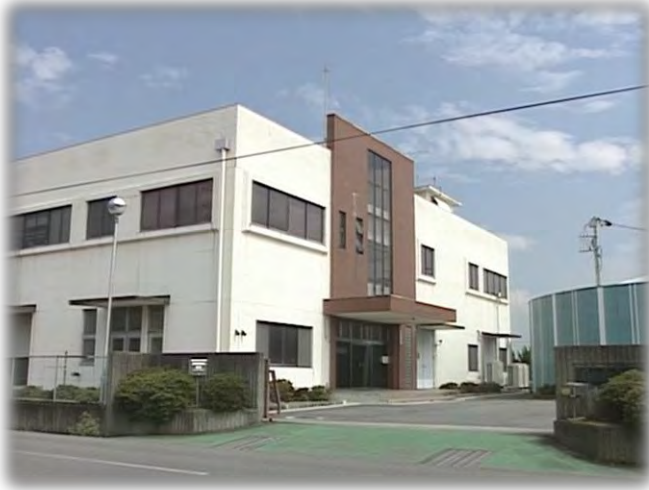
師勝配水場管理棟
