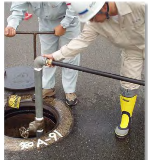
写真 4-14 応急給水訓練
