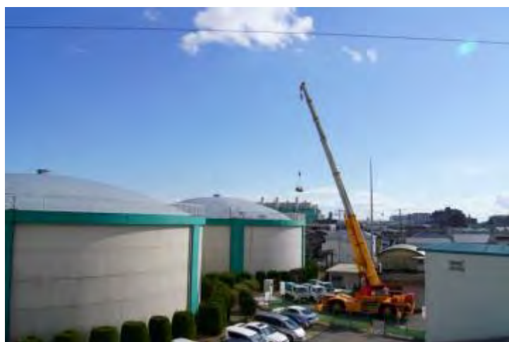
写真 4-6 配水池(中央配水場) (耐震補強工事中)
