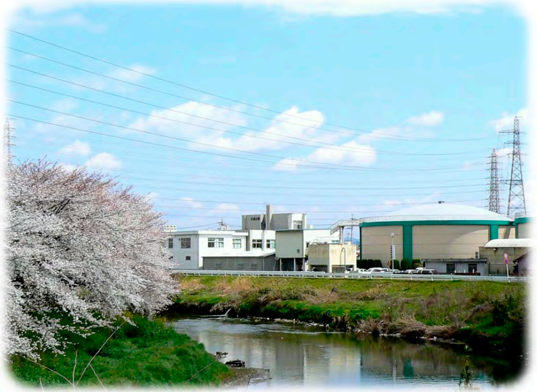
五条川の下流から見た北名古屋水道企業団中央配水場
