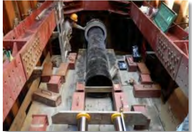
写真 4-9 基幹管路の布設工事
