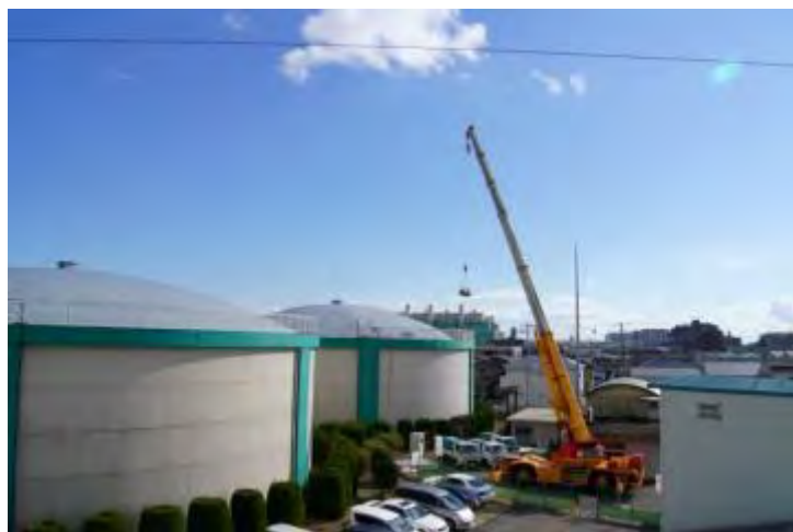
写真 4-6 配水池(中央配水場) (耐震補強工事中)
