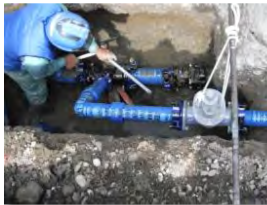
写真 4-8 配水管の布設工事
