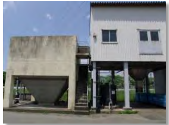
写真 4-28 排水処理施設(中央配水場)
